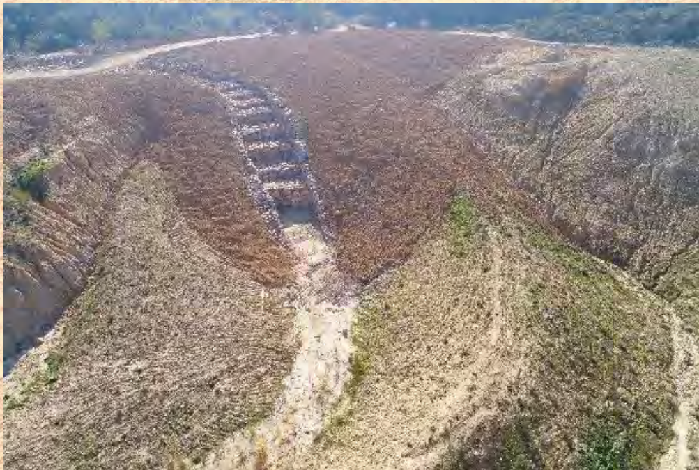
Bajante que conecta el barranco de Roca-corva con el hueco de Pastor I / Rock downdrain that connects the Roca-corba creek with the Pastor I pit
