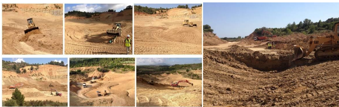
Figura C.1.2-3.3. Ejemplo del dossier gráfico elaborado sobre el proceso de construcción y control técnico de la ejecución, seguimiento y registro gráfico. Las seis imágenes de la izquierda muestran detalles de los trabajos de construcción de diseños geomorfológicos, y la imagen de la derecha ilustra el proceso de construcción de la sección de un meandro fluvial. Dicha sección, equivalente a la de meandros naturales, puede observarse en el corte del terreno.
