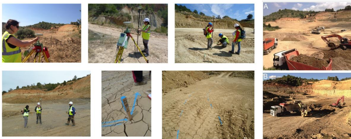
Figura C.1.2-3.2. Ejemplo del dossier gráfico elaborado sobre el proceso de construcción y control técnico de la ejecución, seguimiento y registro gráfico. Las seis imágenes de la izquierda muestran detalles de los trabajos de replanteamiento topográfico y marcado sobre el terreno. Las dos imágenes de la derecha, A y B, muestran el proceso de restauración de Aurora, en el que estuvo implicado un parque de maquinaria elevado.
