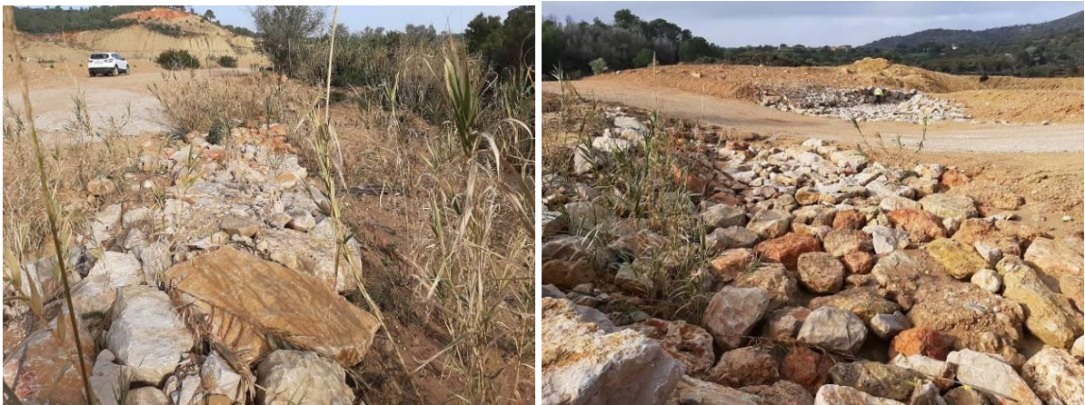
Figura D.6.3. Fotografías tomadas en la derivación del barranco de Rocacorba hacia el hueco de Pastor I, diseñada y ejecutada como resultado de ECORESTCLAY, inmediatamente después de la ocurrencia de la borrasca Gloria. En la imagen de la izquierda puede observarse cómo los limos que transportó el barranco Rocacorba quedaron en el mismo borde de la derivación (apenas unos centímetros por debajo del nivel de rebose), habiendo quedado a punto de desbordar hacia el hueco de Pastor I. En la imagen de la derecha, se muestra la derivación hacia Pastor I, sin limos. Ver texto para la explicación sobre la determinación del valor de precipitación umbral, que ha podido establecerse en el transcurso del proyecto.
