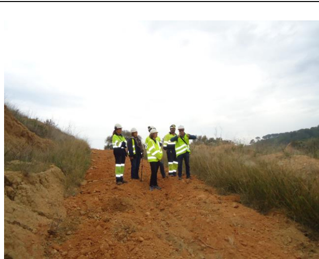
Camino ripado para favorecer la infiltración
