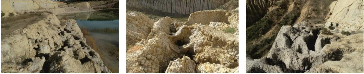
Figura A.1.1. Cavidades formadas por procesos de piping en bermas de la arcillera Pastor I.
