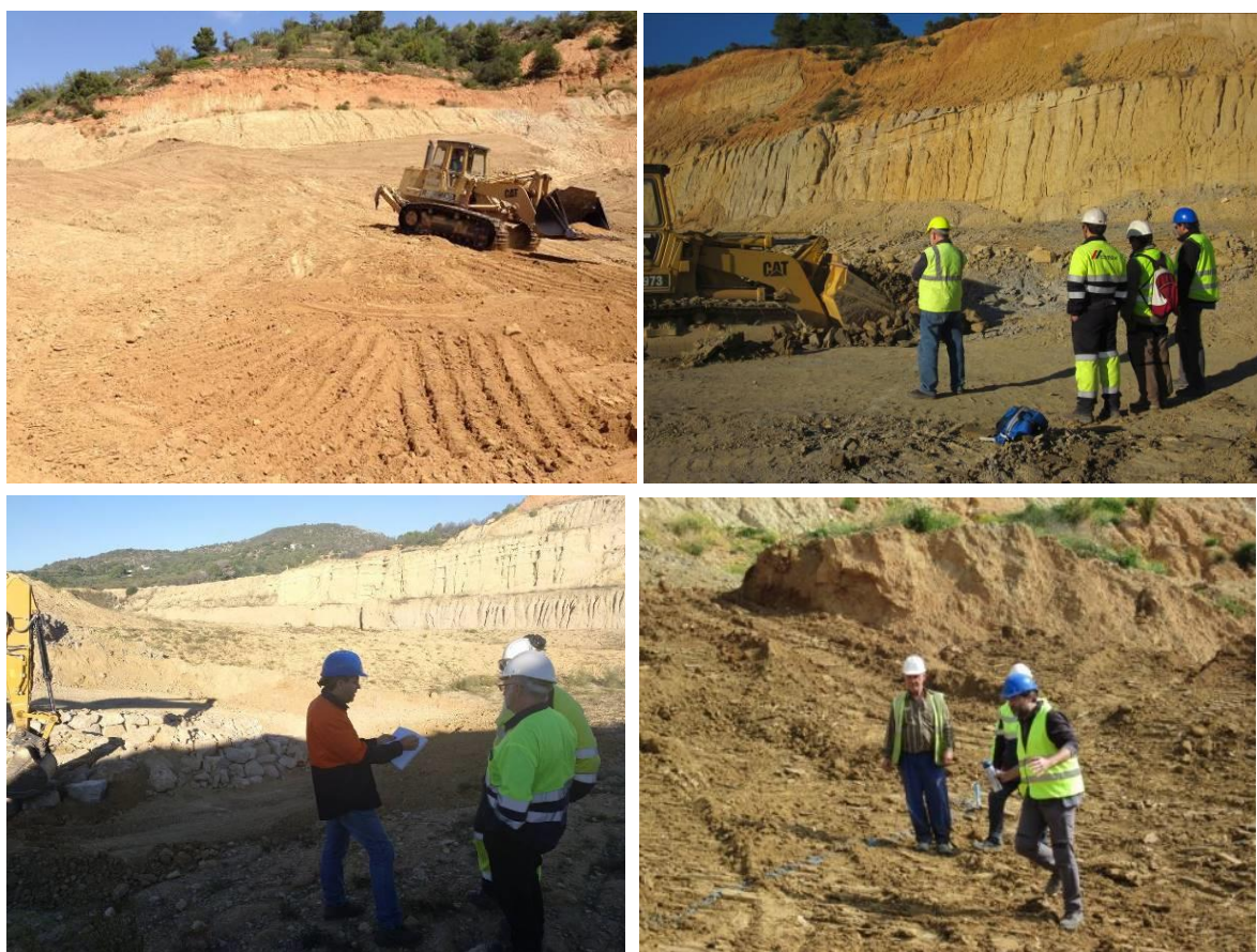
Fotografías que ilustran el proceso de formación de la acción A6. Arriba izquierda, tractor con orugas de pala frontal, encargado de otorgar las formas finales de tipo GeoFluv (ver texto para la explicación de las características específicas de este tipo de maquinaria para este tipo de proceso). Arriba derecha, sesión formativa y demostrativa sobre el terreno, en noviembre de 2014; en esa imagen, Xavier Gombau, Francisco Díaz, José Manuel Nicolau y José F. Martín, de izquierda a derecha, observan cómo Julián Llambrich, operador del bulldozer, ejecuta las instrucciones recibidas. Abajo izquierda, José F. Martín da instrucciones a Xavier Gombau y José M. Gómez. Abajo derecha, Xavier Gombau, Julián Llambrich y José F. Martín recorren una zona replanteada y marcada para su reconstrucción topográfica.
